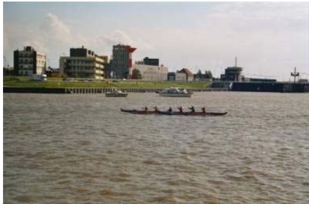
Täufingvor der Doppelschleuse
